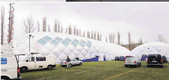
Auf insgesamt 2500 Quadratmetern sollen bis zu 300 Asylbewerber eine Notunterkunft finden. Die Hallen sollen laut Betreiber Berliner Stadtmission bis April 2015 stehen bleiben.
